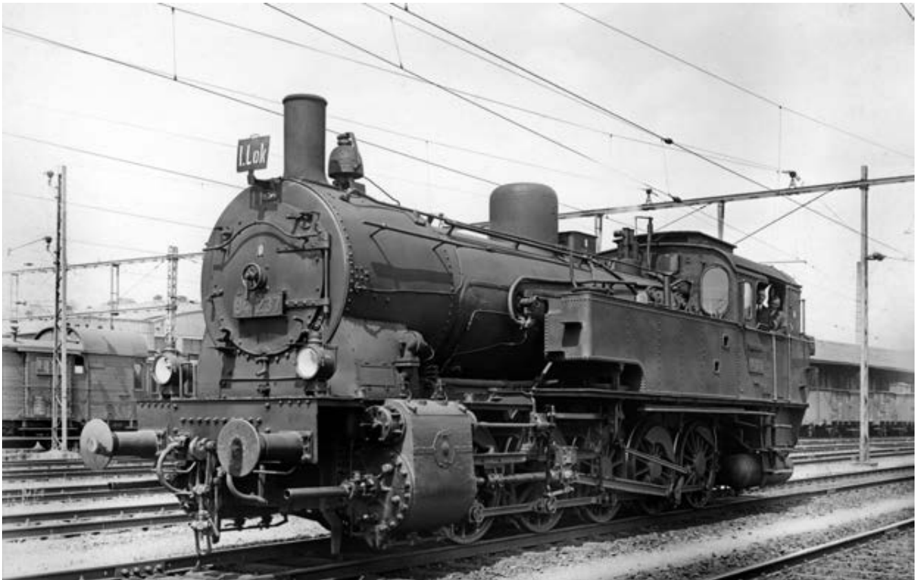
Am 14. Juni 1936 fotografierte Carl Bellingrodt im Bahnhof Hirschberg die 94 237, die auch nach knapp 30 Jahren immer noch ohne Vorwärmer und Kolbenspeisepumpe unterwegs war. Auffällig ist die ungewohnte Fahrleitung mit Quertraversen (Bauart SSW) – die „Elektrisierung“ (wie es damals hieß) war im Bahnhof Hirschberg bereits im Mai 1912 begonnen worden, doch die Aufnahme des elektrischen Betriebes erfolgte erst am 21. Juni 1920. Das Schild „I. Lok“ an der Rauchkammer weist die Maschine, deren Lokführer im Dienst sogar eine Krawatte trug, als Rangierlok eines bestimmten Rangierbezirkes aus.
