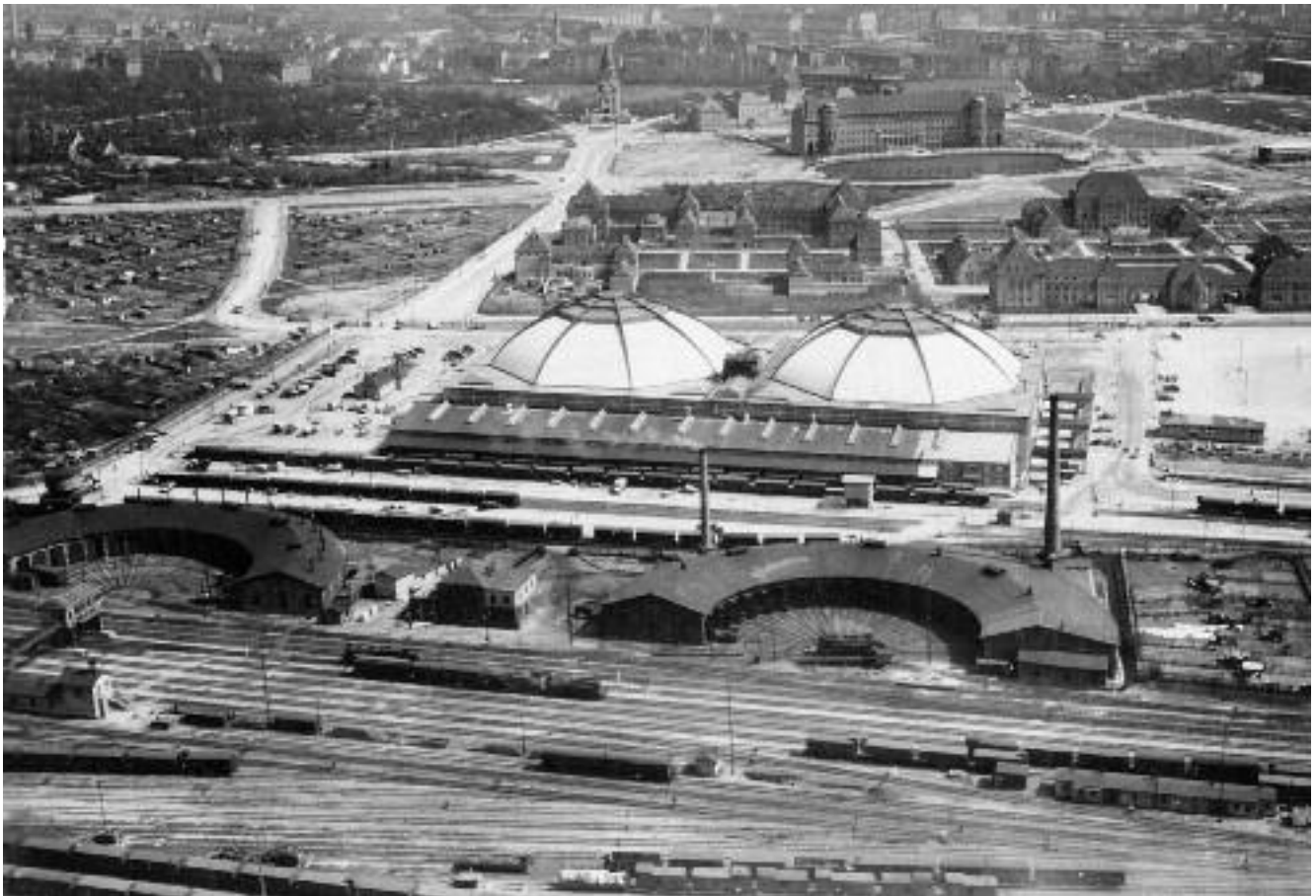
Um 1930 entstand dieser Blick auf die zwei Kuppeln der Leipziger Großmarkthalle. Im Vordergrund sind die Gleisanlagen sowie die beiden Lokschuppen des Bahnbetriebswerkes Leipzig Bayerischer Bahnhof, im Hintergrund die Russische Gedächtniskirche sowie die Deutsche Bücherei (oben rechts) zu sehen. Auffällig sind auch die zahlreichen Güterwagen auf den Gleisen der Markthalle – damals wurde halt noch fast alles mit der Bahn antransportiert. Foto: Sammlung Stadtarchiv Leipzig
