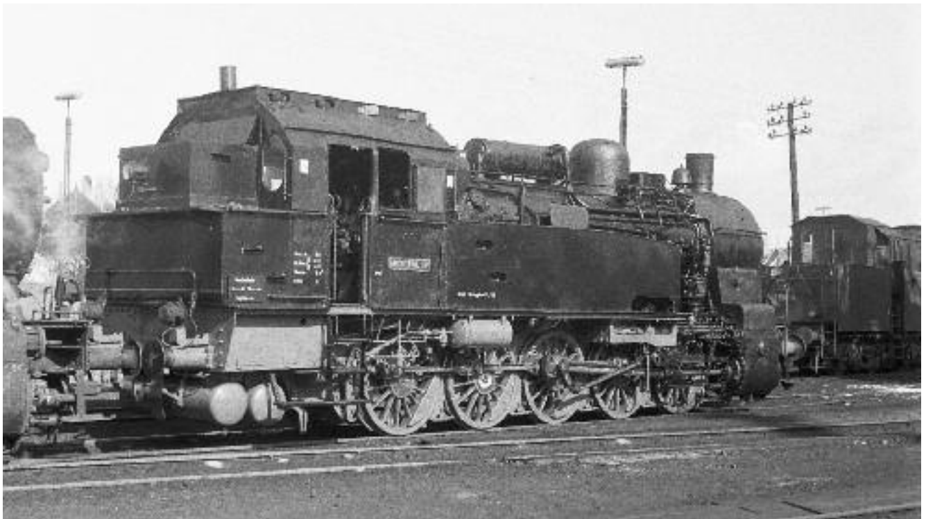
Bei einem „illegalen Besuch“ im AW Lingen am 3. April 1970 (siehe Kapitel 1) konnte einer der beiden Autoren die Lok „MONOPOL IV“ (ex 94 1283) fotografisch festhalten. Die Maschine hatte keinen Speisedom, aber eine Rangierfunkanlage.
