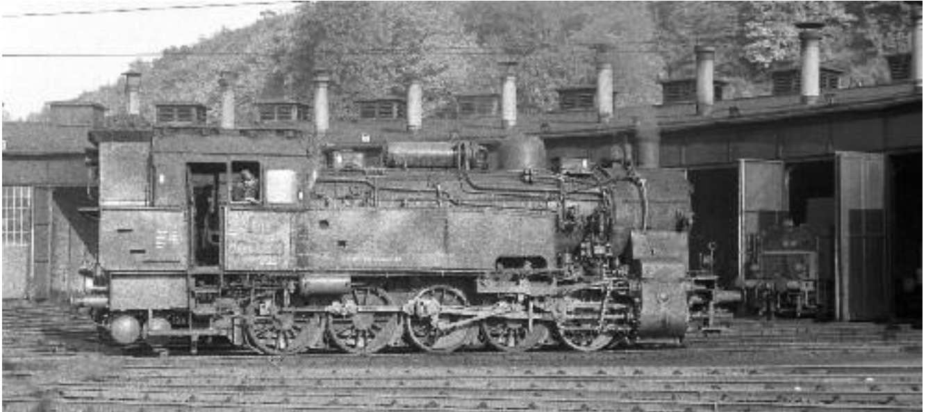
Bei der gleichen Gelegenheit (siehe Vorseite) entstand auch diese Seitenaufnahme, auf der deutlich zu erkennen ist, dass die Lokomotive 094 533 durch einen Kesseltausch (BMAG 1915/ 5718) keinen Speisedom mehr besaß. Dadurch ist aber der Oberflächenvorwärmer, der auf dem Kesselscheitel saß, besonders gut zu sehen. Zwischen Schornstein und Glocke war gerade noch genug Platz für den Schalldämpfer der Gegendruckbremse.
