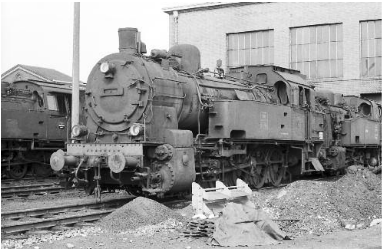
Im Jahr 1971 erhielten die „Monopol-Lokomotiven“ neue Betriebsnummern nach dem Schema der Ruhrkohle-AG. Die „MONOPOL IV“ wurde bei dieser Gelegenheit in RAG D-791 umgezeichnet. Beim Vergleich mit der Aufnahme aus dem AW Lingen fällt auf, dass die Maschine zwischenzeitlich ihren Oberflächenvorwärmer verloren hatte. Foto: Uwe Bergmann
