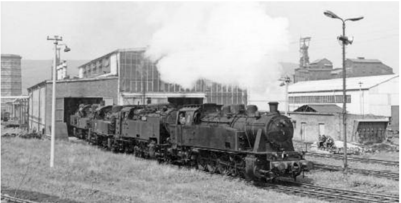
Am 5. Mai 1973 konnte man im „VEB Kalikombinat Werra“ einen Lokzug mit fünf Maschinen beim Verlassen der 1967 gebauten Hauptwerkstatt Merkers bewundern. Es handelte sich um die Lokomotiven mit den Betriebsnummern 10, 3 (beide siehe Kapitel 6.6), 6, 26 (die Henschel-T16 1 ) und eine nicht identifizierte. Im Hintergrund einer der beiden noch heute existierenden Fördertürme. Foto: Sammlung Gerhard Moll
